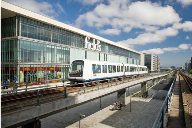
Bild 2. U-Bahn-Station am Einkaufszentrum „Field’s“
