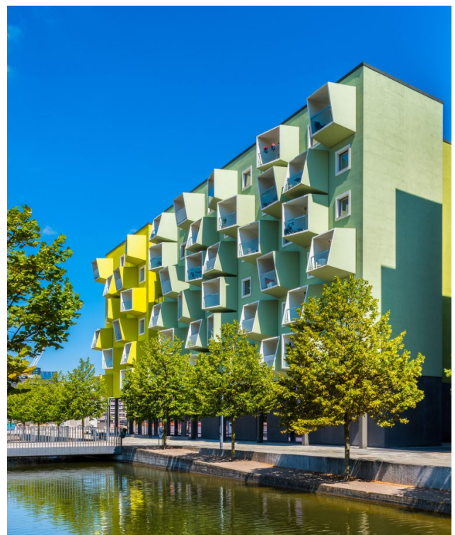
Bild 10. Westfassade des Ørestad Plejecenters in Richtung Kanal
