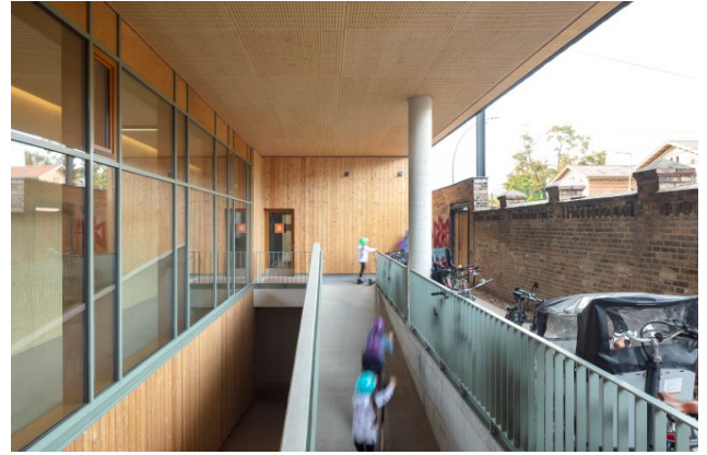
Bild 3. Zugang zum Fahrradkeller
