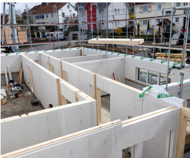
Bild 6. Fertigstellung der Holzständerwände im EG
