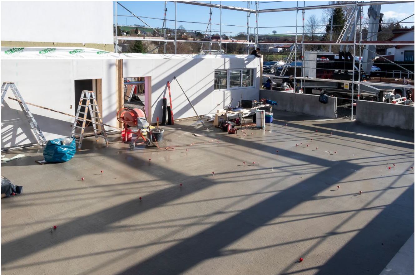
Bild 3. Bodenplatte aus Stahlbeton
