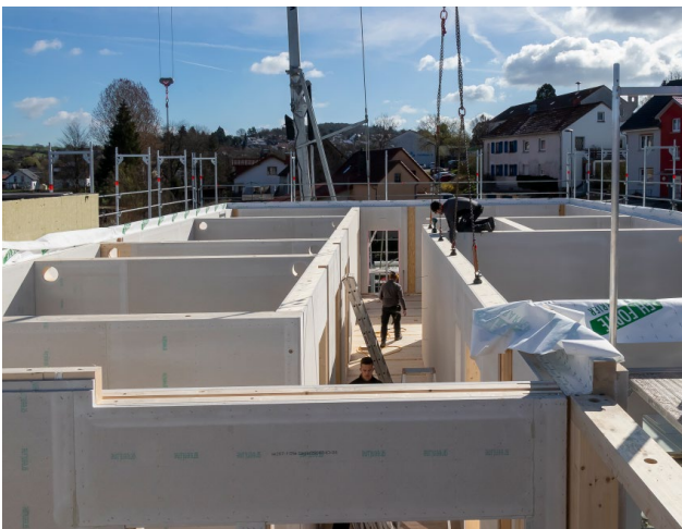
Bild 11. Fertigstellung der Holzständerwände im 1.OG
