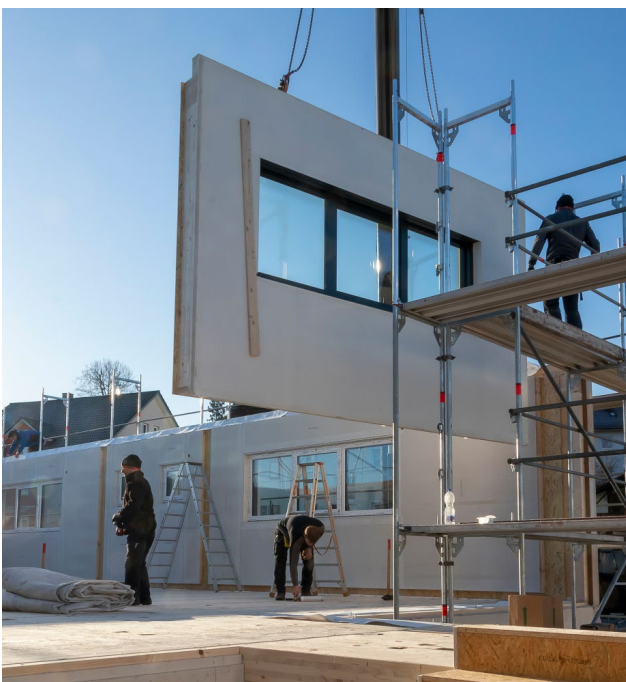
Bild 2. Montage Wandelement im 1.OG
