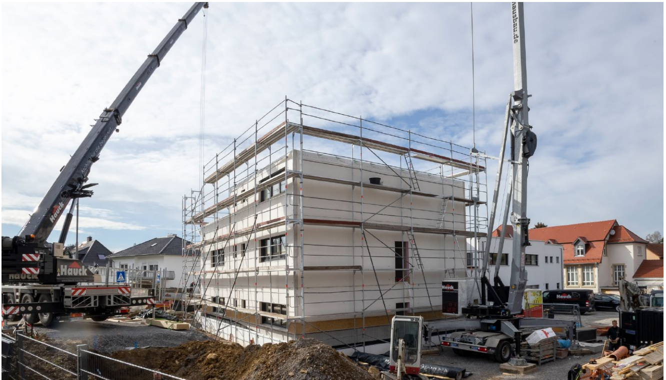
Bild 8. Blick auf den Büroanbau
