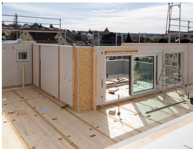
Bild 14. Blick auf die Terrasse im 2.OG
