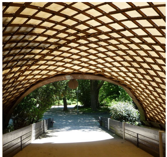
Bild 8. Eingang zur Multihalle von Innen
