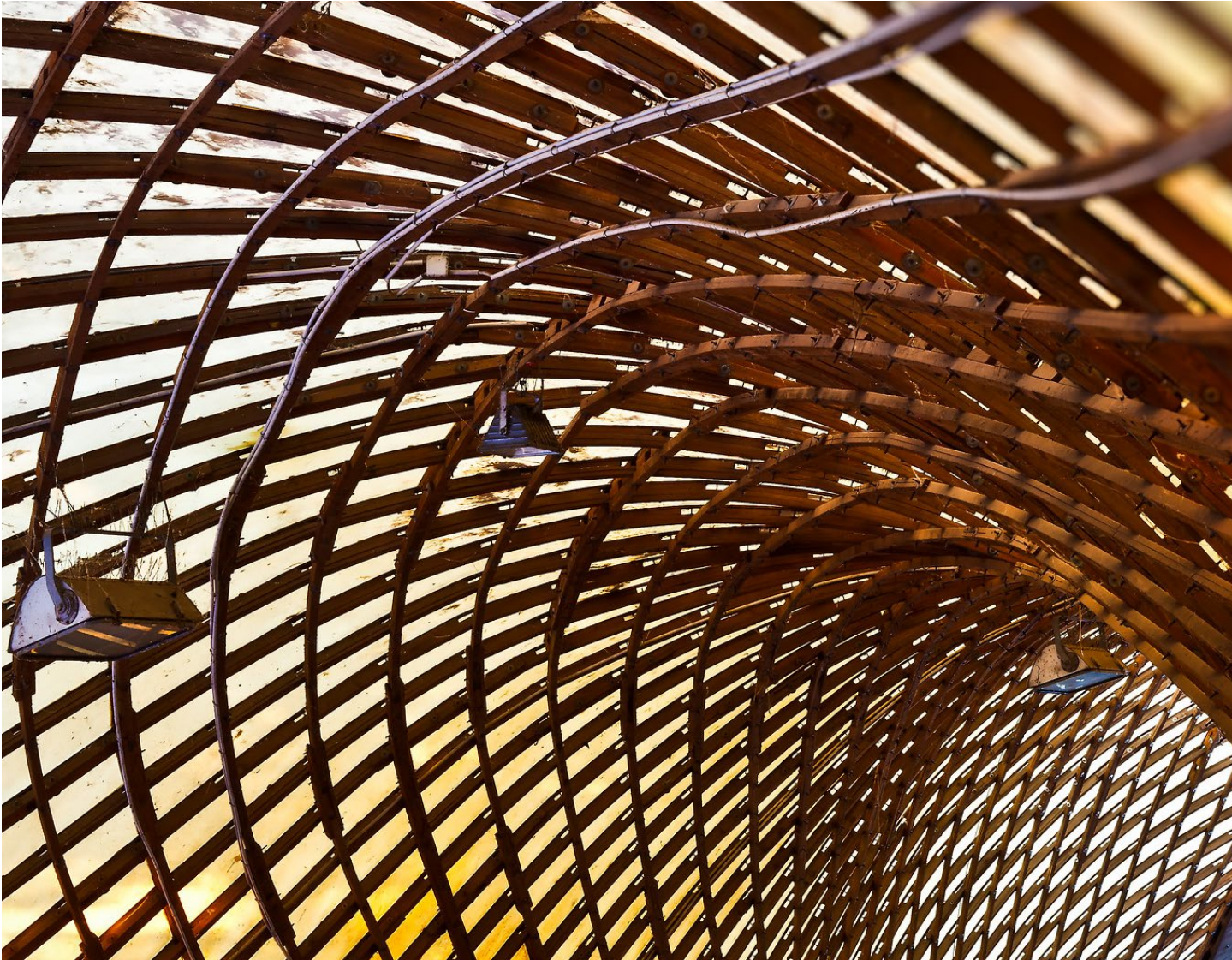
Bild 6. Hochkomplexe Dachstruktur im Detail
