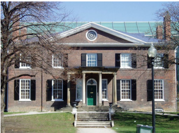
Bild 3. Südansicht Herrenhaus Grange im Jahr 2004
